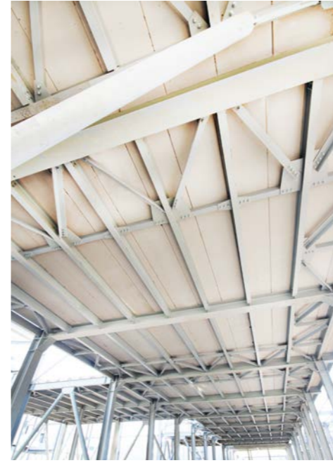
Sancaktepe İşitme ve Konuşma Engelliler Eğitim ve Rehabilitasyon Merkezinde Ytong Blok ve Çatı plakları kullanılmıştır.
