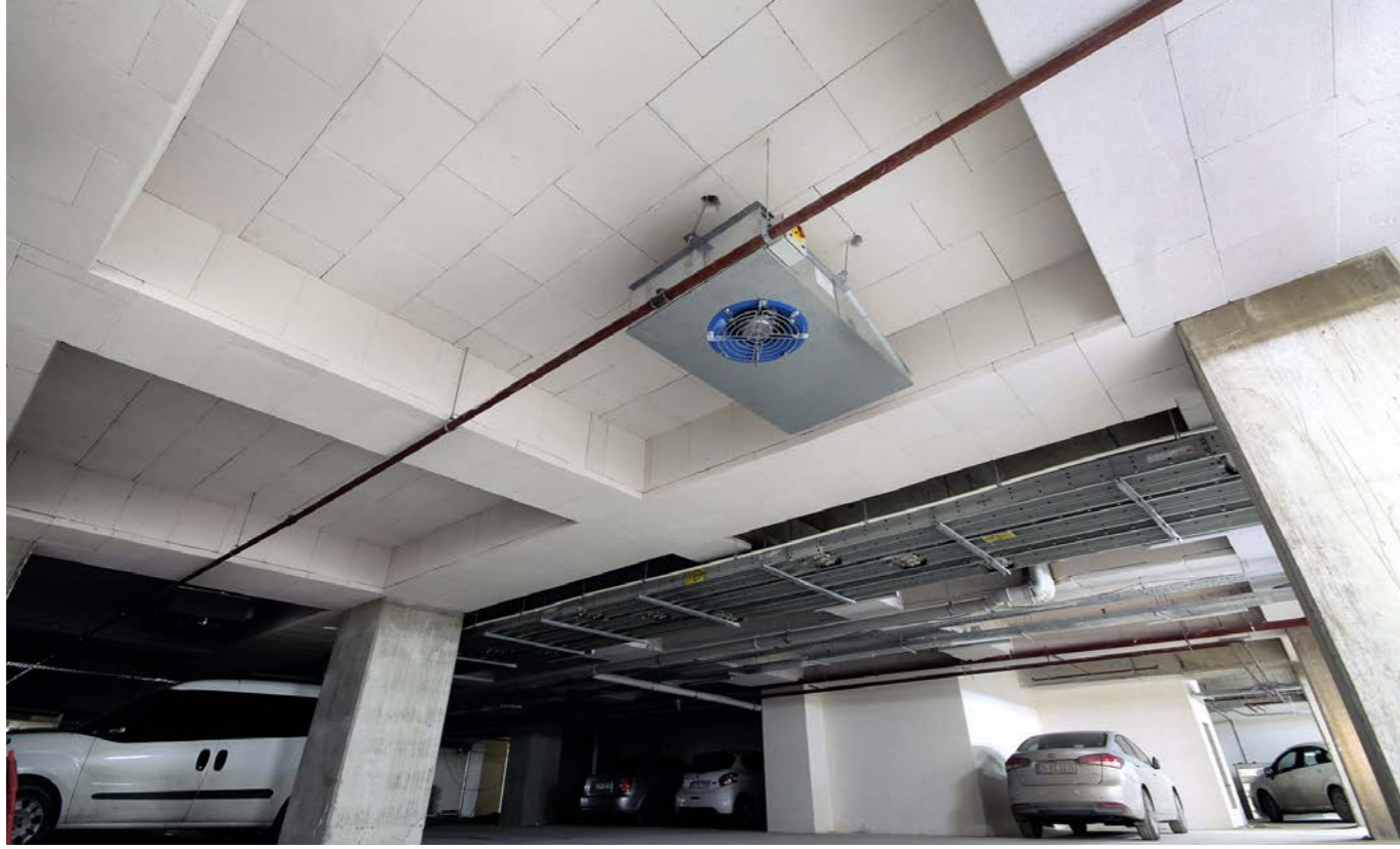
Anatolium Marmara Alışveriş Merkezi projesinde, otopark tavanlarının ısı yalıtımında Multipor Isı Yalıtım Levhası kullanıldı.
